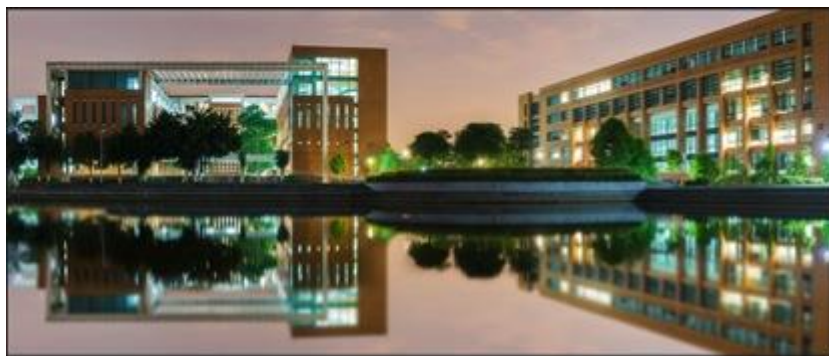
大学城灯火璀璨的教学楼
