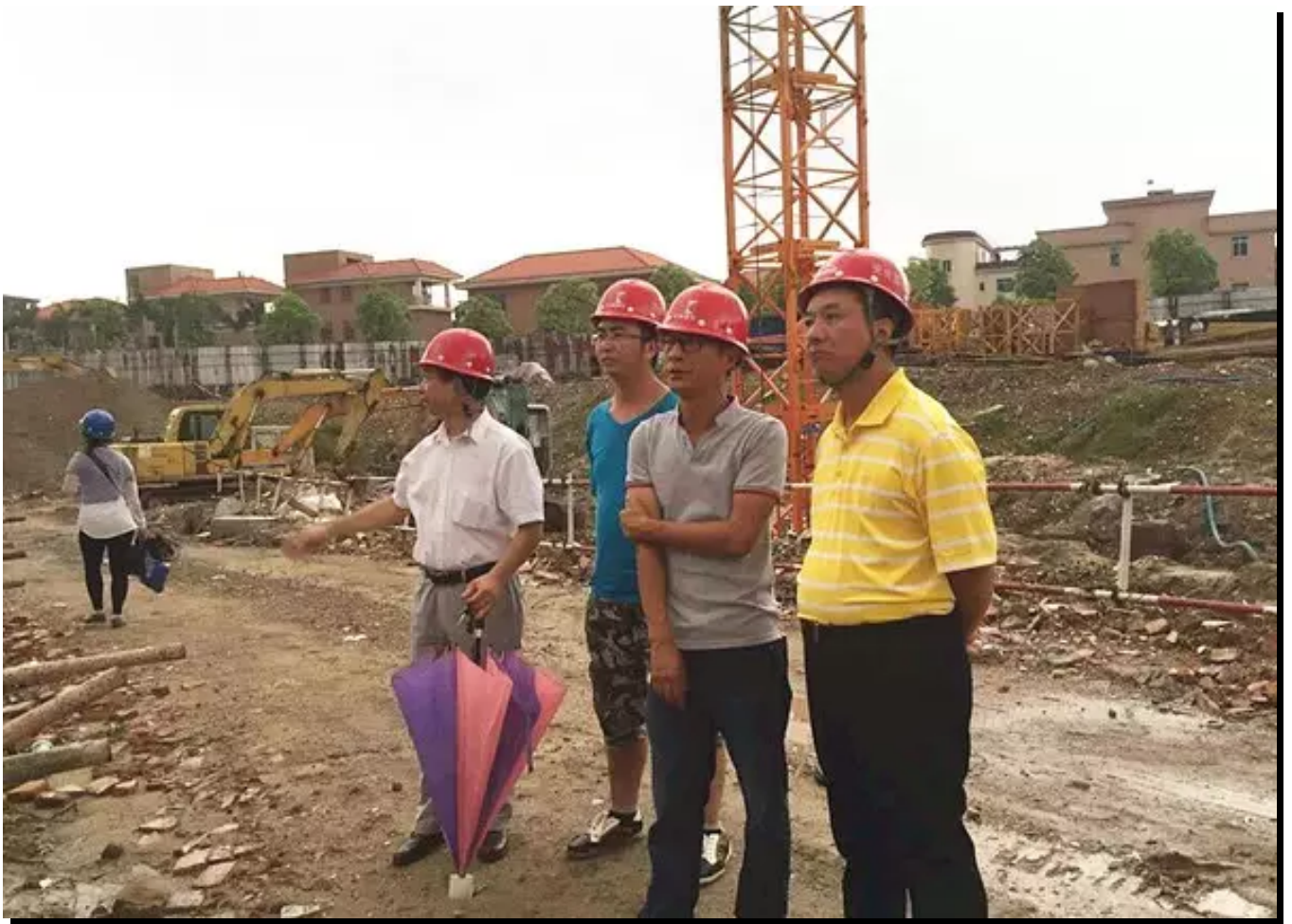
滕鹰（右一）在工地视察
